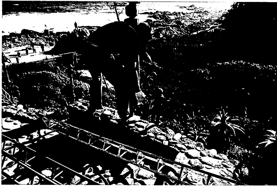
Foto N° 5. Vista del proceso de retiro de cadenas perimetrales previo al encarpado.
