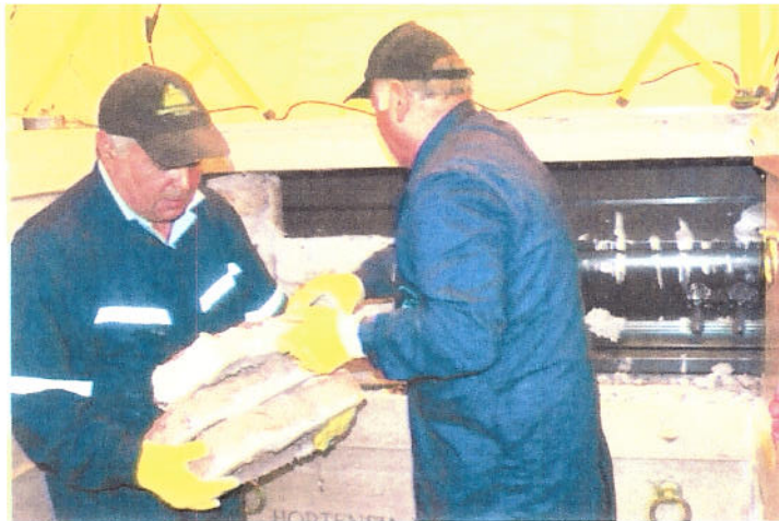
Foto N° 8. Vista del retiro del muro de ladrillos.
