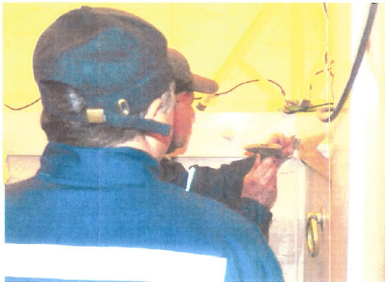
Foto N° 6. Remoción por medios manuales de la lápida de mármol del nicho del Presidente Salvador Allende Gossens.
